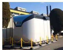
業務用燃料電池の 電気・熱・CO 2 を活用 (トリジェネレーション)
