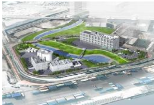
大阪市咲洲地区の蓄電池評価センター【NLAB】 (平成28年2月完成、平成28年夏以降、試験サービス開始予定)
