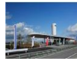
水素ステーション
