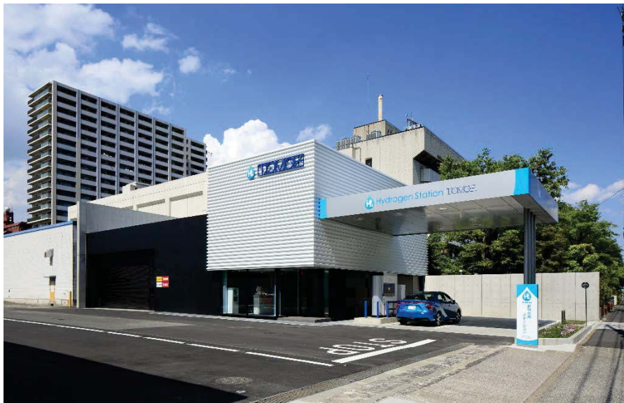
新砂水素ステーション
