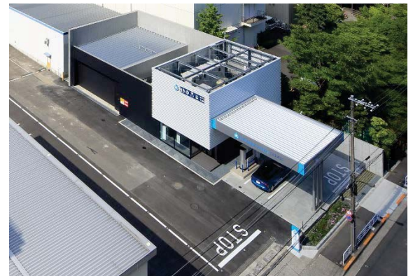
水素ステーション全景
