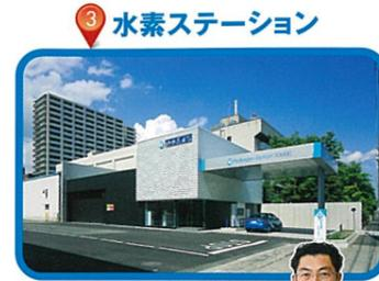
水素ステーションに加え、蓄電池、発電機、EVなどの電源リソースを直流で統合するMSEG<sup>®</sup>を完備。EVからの給電も可能です。
