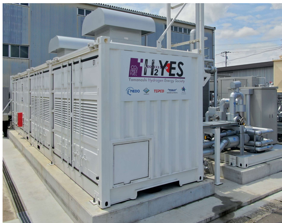
左：基本パッケージ（変電設備、水素製造装置） 右：補機パッケージ（純水装置、冷却塔）
