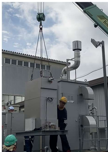
MHタンクの搬送作業と車載状況
