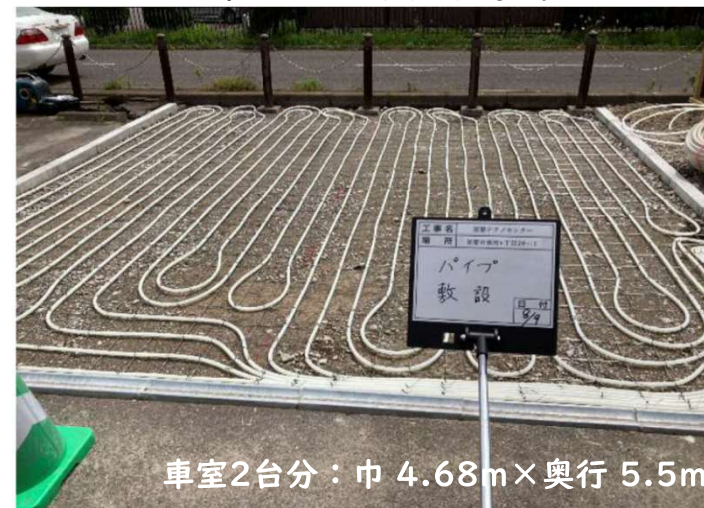
ロードヒーティング用熱媒パイプ敷設
