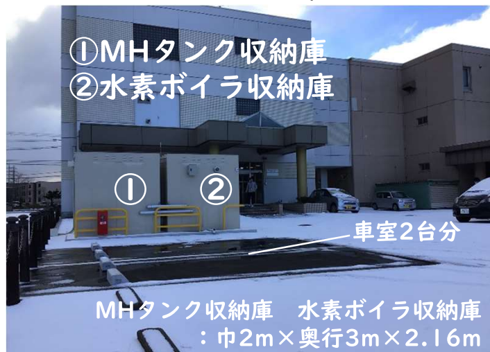
ロードヒーティング稼働状況
