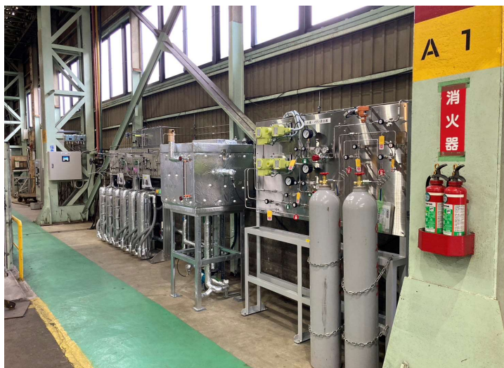
金属切断機用MHタンク置き場
