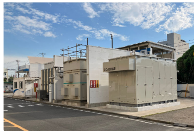
二酸化炭素回収装置実証機(手前)、小型水素製造装置「HyGeia-A」(中央)
