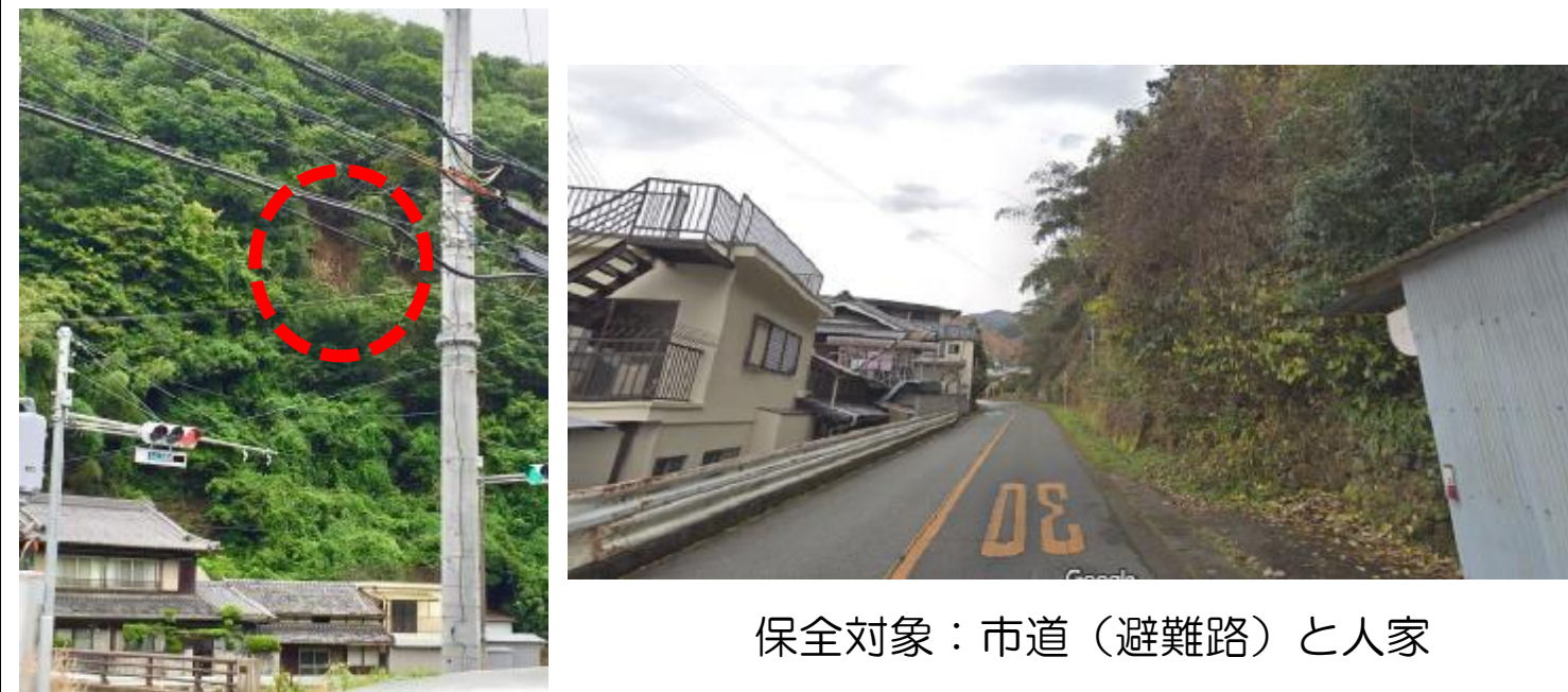
斜面崩壊の状況
