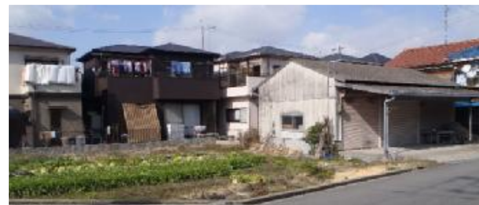
保全対象（人家）
