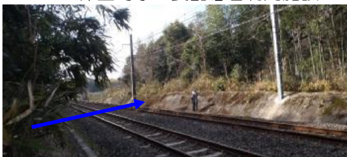
保全対象：鉄道
