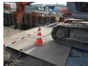
汚染土壌掘削工事の 現地確認状況
