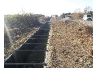
堺第7-3区での排水路改修工事
