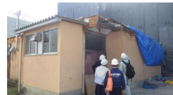
解体現場の立入調査
