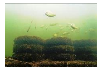
環境改善モデル設備の設置状況
