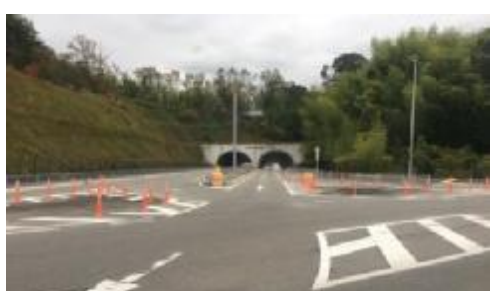
④終点部から起点部
