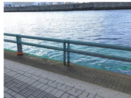
大阪湾の護岸の様子
