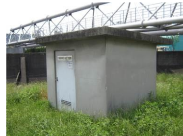
地盤沈下・地下水水位観測所
