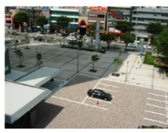
透水性・保水性舗装
