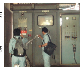
PCB廃棄物に係る立入検査
