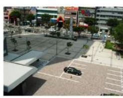
透水性・保水性舗装
