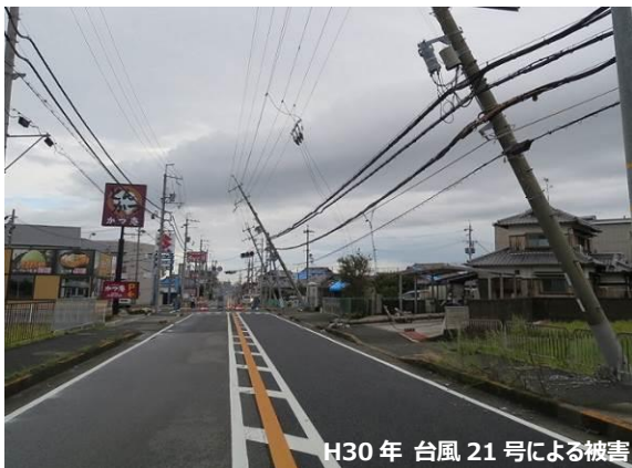
【電柱倒壊等による道路閉塞】
