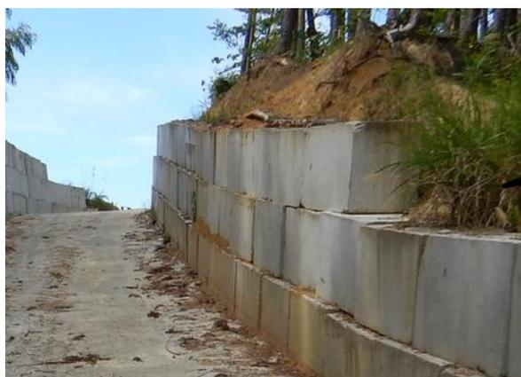
立米ブロック（1m×1m程度の大きさのコンクリートブロック）を積み上げて擁壁として利用
