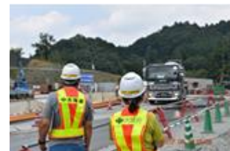
流入車規制の立入検査
