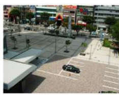
透水性・保水性舗装
