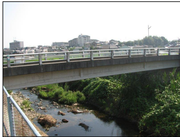
図3 狭山池合流直前の状況
