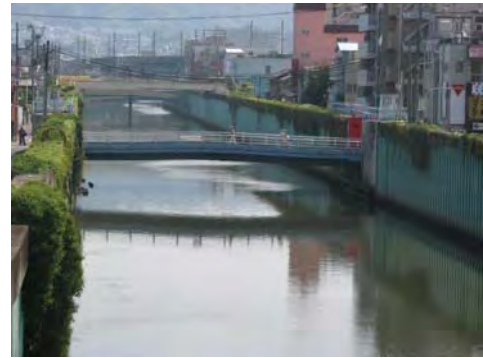
恩智川（住道新橋）
