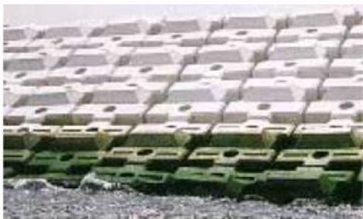
図4 大阪沖埋立処分場の緩傾斜護岸
