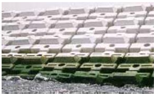
図4 大阪沖埋立処分場の緩傾斜護岸
