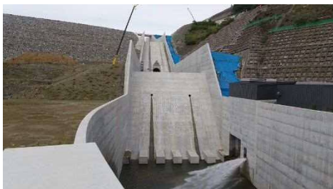
安威川ダム放流側
