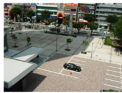
透水性・保水性舗装
