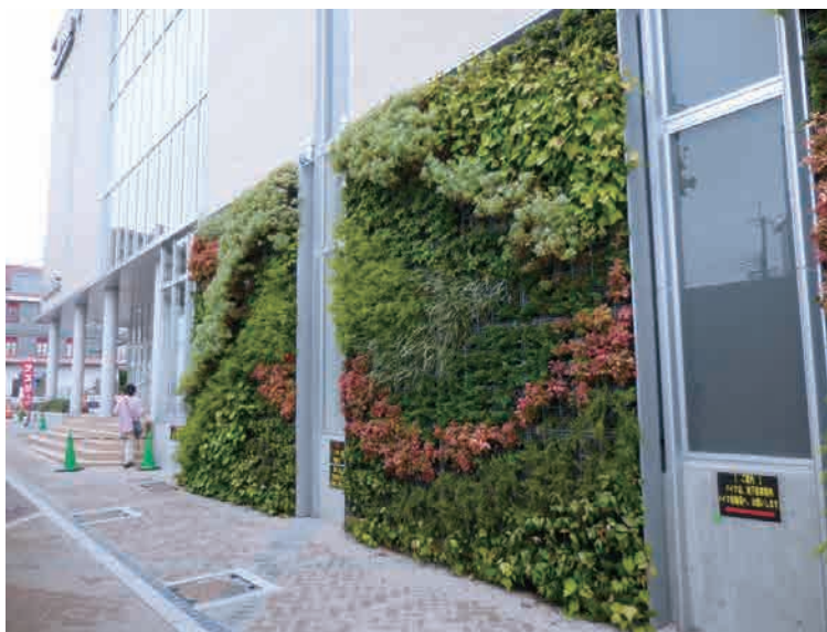
敷地南側の壁面緑化は駅前広場に彩りを提供
