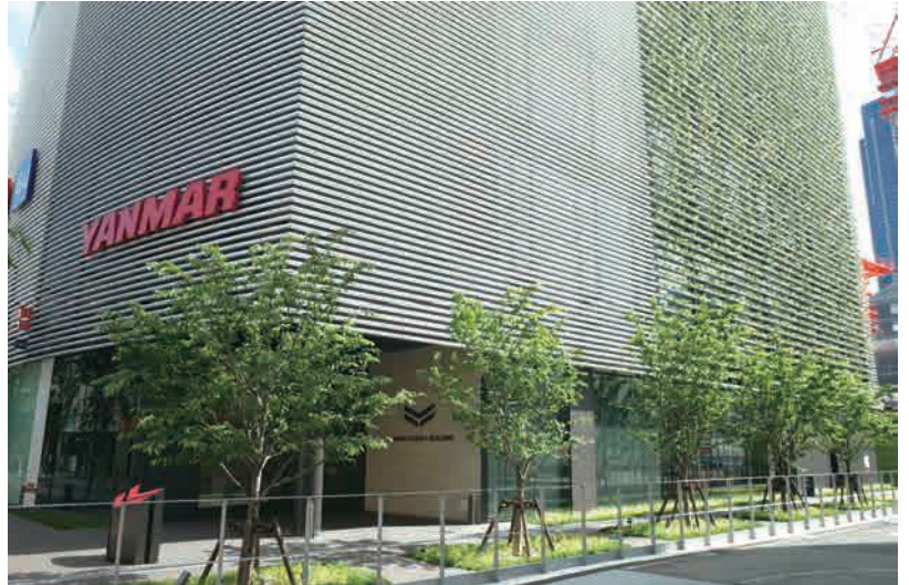
外装と一体となった植栽ルーバーによる高さ5.2mの国内最大級の壁面緑化
