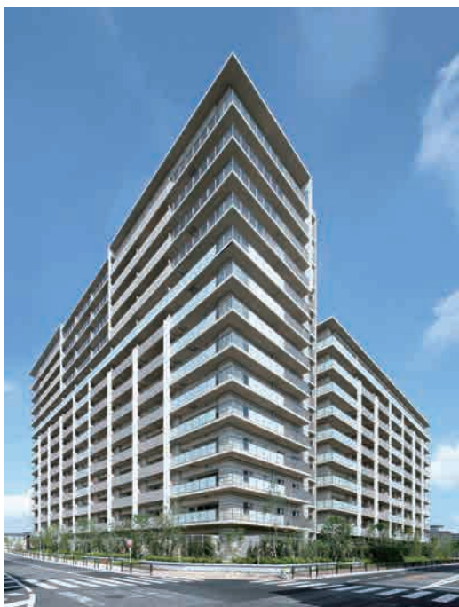
建物の足下を取り巻くように設けられた植栽帯
