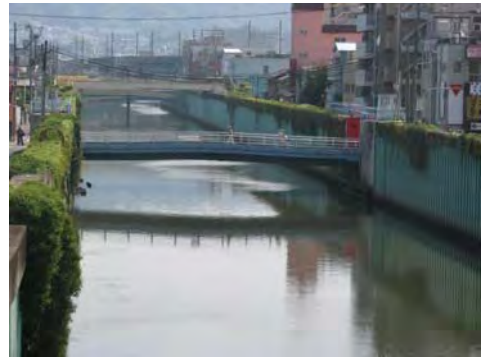
恩智川（住道新橋）
