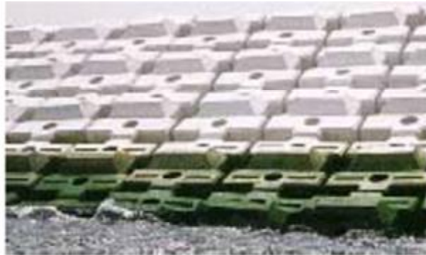
図 28 大阪沖埋立処分場の緩傾斜護岸
