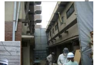
解体現場立入検査
