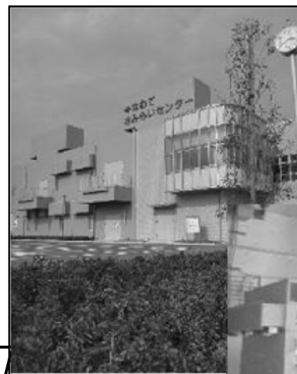
なわて水みらいセンター 管理棟
