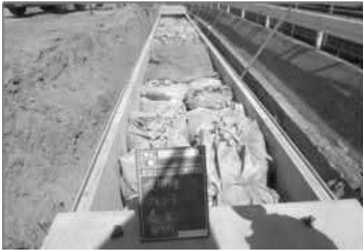
コンクリート製ボックス内保管状況
