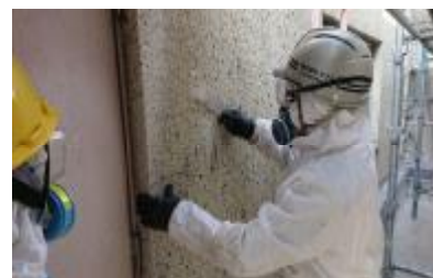
剥離剤併用手工具ケレン工法
