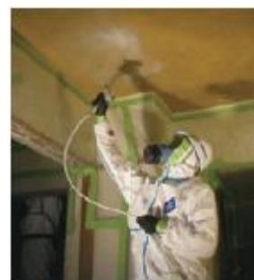
粉じん飛散抑制剤の散布による湿潤化
