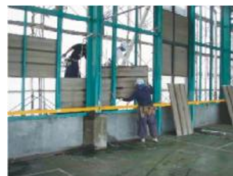
石綿含有建材の手ばらしによる除去
