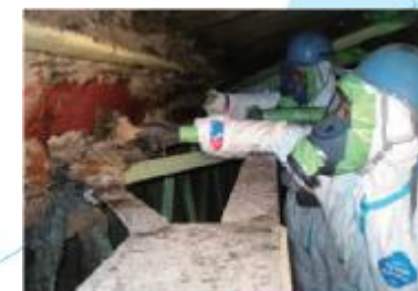
手工具(ヘラ)を使用した石綿含有吹付材の除去作業
