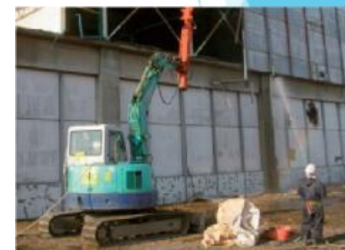
石綿含有建材への散水
