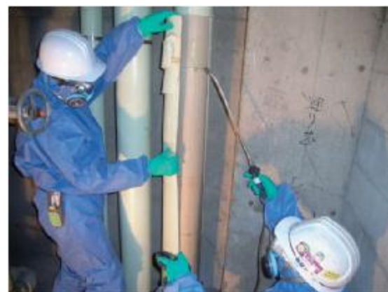
保温材の湿潤化・除去
