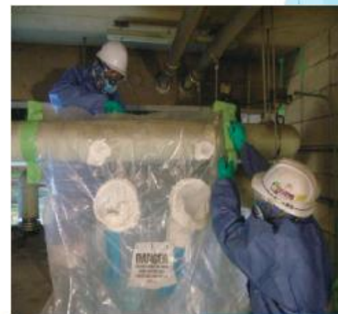
グローブバッグによる除去作業例
