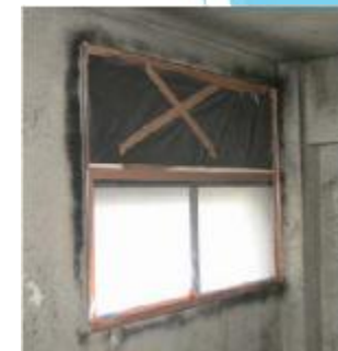
窓、換気口の養生例
