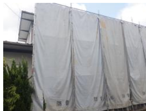
飛散防止幕の設置
