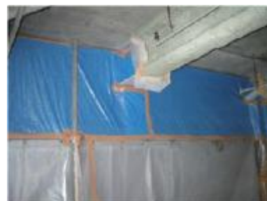
壁面の隔離養生例
