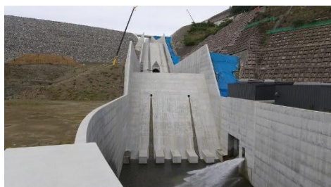
安威川ダム放流側
