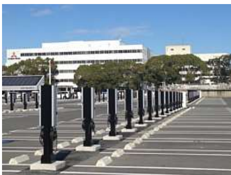
写真Ⅲ-3-1 従業員駐車場への充電設備設置 (出典) 三菱自動車工業(株)HP
