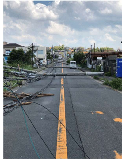
図Ⅱ-3 2018年台風第21号による電柱倒壊（泉南市） 出典：令和元年版防災白書
