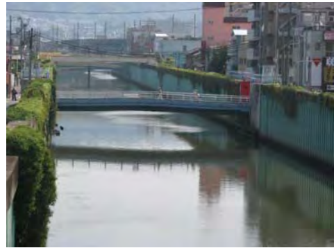
恩智川（住道新橋）
