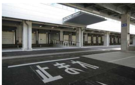
水産仲卸売場棟高床式バース
