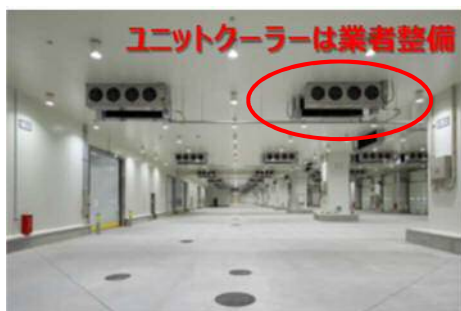
水産卸売場棟施設内状況
