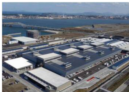
屋上太陽光発電
