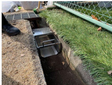
フィルター設置
