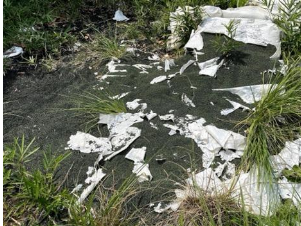
管理区域外に置かれた充填材が露出し、外部へ流出している様子
