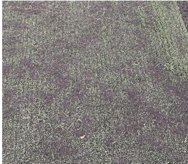
充填材が露出した人工芝グラウンド
