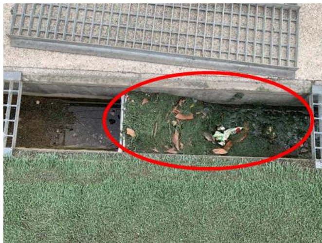
雨天後に側溝内に流出した大量の人工芝片
