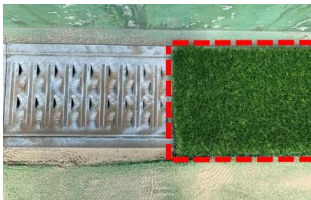
側溝上部に取り付けた人工芝蓋カバー
