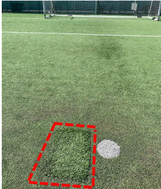
ペナルティマークの軸足部分を部分的に修繕した様子
