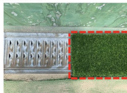
側溝上部に取り付けた人工芝蓋カバー
