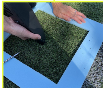
①ゴール前：ゴムチップ吸引、目砂は一部のみ
