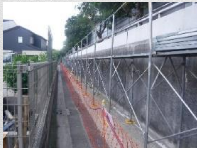
防潮堤の嵩上げ工事
