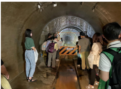
【排水トンネル見学の様子】
