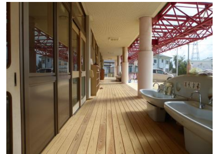
施工例 (デッキ)
