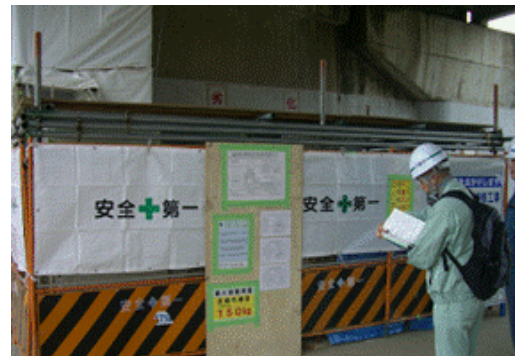
解体現場への立入検査
