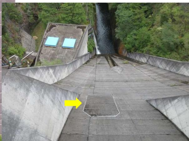
これは、堤体の建設工事の際に使用していた「クライミングクレーン」が立っていた場所です。クライミングクレーンは、高層ビルの建築現場では良く見られますが、ダム建設工事に使用したのは、当時、全国的にも非常に珍しいものでした。下は、建設中の1979年頃に撮られた写真です。ダムの堤体の中から灰色の鉄骨製の柱が垂直に立ち上がり、その上部にある赤色の機械がクライミングクレーン本体です。このクレーンで、必要な資材を必要な場所へ次々に運搬し、堤体の高さが上がると共に、クレーン自体も上昇(クライミング)しながら建設作業を進めていきました。
