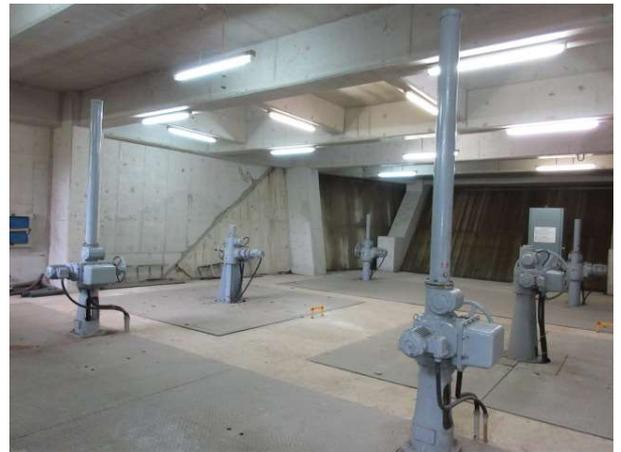
さて、利水バルブ室の隣にある、半地下式の建物は「維持用水バルブ室」です。石川の環境の維持のため一定量の水を放流しなければならないので、こちらからも常に水を放流しています。ここには直径 400mm のジェットフローゲート(主バルブ)とスルースバルブ(副バルブ)が設置されています。これらのバルブの調節も、管理事務所から遠隔で操作することができます。
