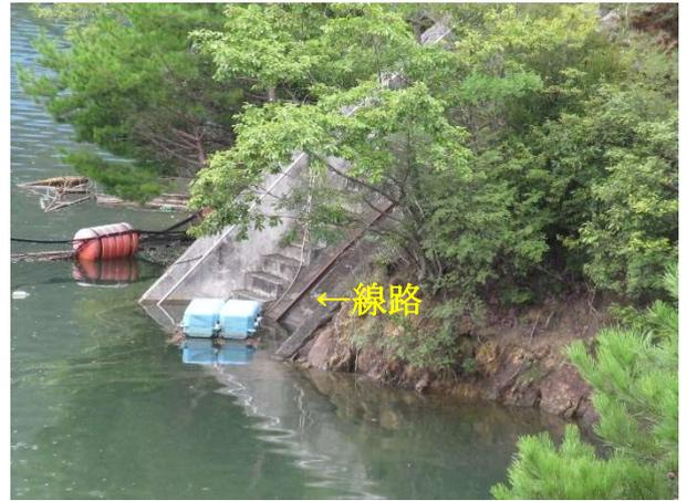
これは「インクライン(incline=傾斜鉄道)」と呼ばれるもので、ダムを管理するために使用するモーターボートを載せた台車が急傾斜の線路の上を移動して、水面とボート庫の間を昇降する設備です。
