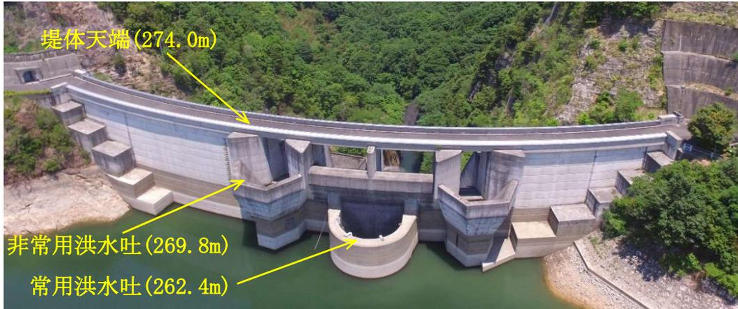
低いほうの洪水吐は「常用洪水吐」で標高は262.4m。これがいわゆる通常の「満水位」で、この状態の貯水量は前に述べた594万 $m^3$ (①)です。高い方の洪水吐は「非常用洪水吐」で標高は269.8m、この状態の貯水量は934万 $m^3$ (②)です。これは、通常の満水位の状態から豪雨が降った場合でも、ダムに流れ込む洪水を徐々に一時的にダムに貯めて下流の石川への洪水を抑える仕組みで、②-①=340万 $m^3$ の洪水を調節する能力があります。(注意：ダムの天端から洪水吐を覗くのは大変危険です)
