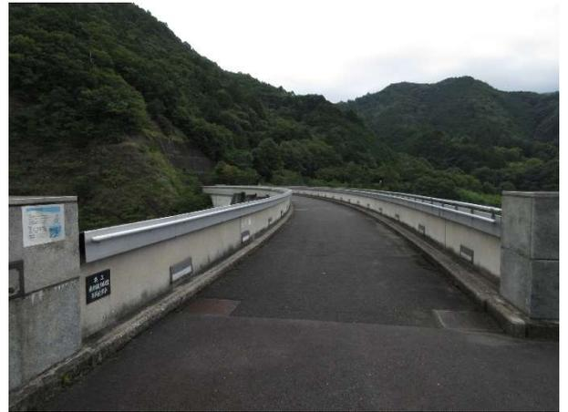
滝畑ダムの堤体の頂上部[=堤頂(ていちょう)]の標高は274m、堤体の長さ[=堤長(ていちょう)]は120.5m、ダムの高さ[=堤高(ていこう)]は62mで、大阪府内にあるコンクリートダムでは最高です。
