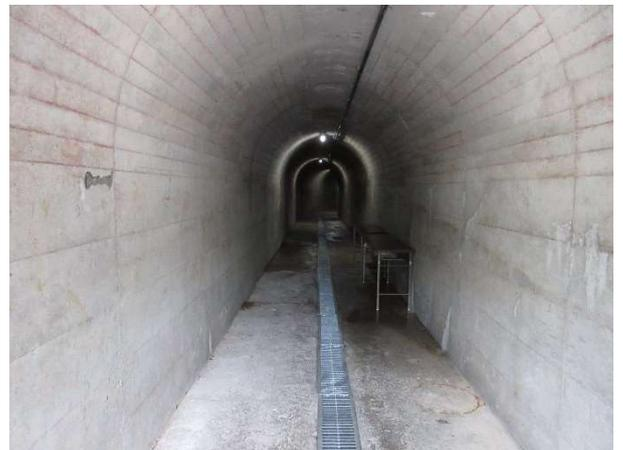
ダムは、幅の狭い谷にコンクリートの壁を造り貯水するのですが、それだけでは水は堤体の左右の山に浸み込んで、水が思うように貯らなかったり、下流の山の不必要な所から水が噴き出したりする不具合が起こり得ます。そこで、堤体を建設する際に、左右の山に15本のリムトンネルを掘削し地質の調査を行うと共に、ここから山の中にセメントと水を混ぜた「セメントミルク」を注入し水の浸透を遮る「地中壁」を造成しました。この作業を「カーテングラウチング」といいます。床面には、その注入作業を行った孔が残っています。なお、現在、人が出入りできるリムトンネルは、堤体の西側に残るこの1本だけです。このリムトンネルに入ると、監査廊と同様に、奥に入るほどほぼ一定の温度になります。この特性を活かして、河内長野市の地酒をリムトンネル内に長期間存置して熟成させたものを、市のふるさと納税の返礼品として提供する取り組みを、大阪府、河内長野市、酒造会社らの官民連携で進めています。(詳しくは河内長野市のふるさと納税のHPをご覧ください)
