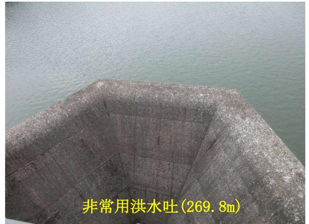
なお、滝畑ダムが完成して以来、自然に降る雨により非常用洪水吐まで貯水位が上がったことはありません。1989年には、ダム堤体の試験のため、常用洪水吐を閉鎖してダムに流れ込む雨水を徐々に貯め続け、非常用洪水吐の高さまで貯水する「試験湛水(しけんたんすい)」を行いました。この時が滝畑ダムの最高貯水位です。
