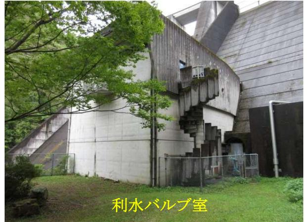
ここは、後の探検で出てくる、「取水バルブ室」を経由した水を、浄水場に送る水道用水と石川に放流する農業用水の水量を調節する施設です。内部には直径 800mm と 400mm の 2 基のコンスリーブバルブが設置されており、夏季(6月上旬～9月中旬)とその他の季節により切り替えながら、放流量を調節しています。これらのバルブの調節は、管理事務所から遠隔で操作することができます。
