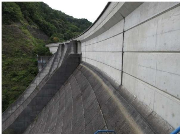
コンクリートの表面に雨水が良く当たるなど、普段から水分が多い部分では、ここに微生物(バクテリア)が繁殖しやすくなります。これらの微生物が死んだ後、微生物の体を構成していた炭素成分が表面に固着することで、だんだん黒ずんできます。上部の白い部分では、堤体の天端部分が外側に張り出しており、表面に雨が当たりにくく、微生物の繁殖が下の方よりも抑えられるため、長い間にこのようなツートンカラーになってしまいました。
