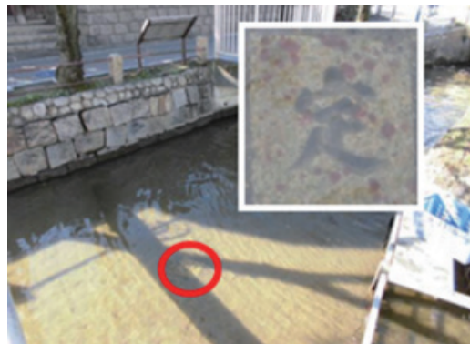
③定石(さだめいし) 玉串川井樋前に現存。干ばつになってもこの石が水面から出ないように管理した ※①② 資料提供協力: 柏原市立歴史資料館
