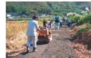
未舗装農道の舗装
