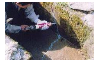
水路のひび割れ補修
