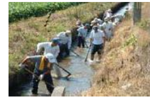
水路の泥上げ
