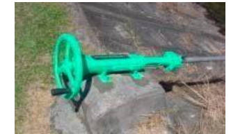
ゲート・バルブの更新
