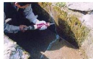
水路のひび割れ補修
