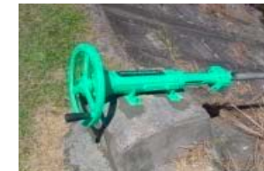
ゲート・バルブの更新
