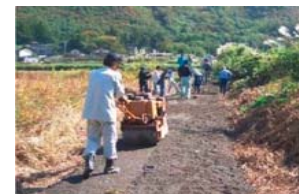
未舗装農道の舗装
