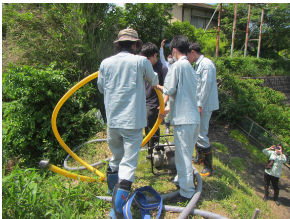
写真5 設置場所まで運搬
