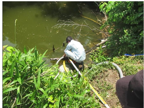
写真8 水中で吸込み口の蓋を開ける
