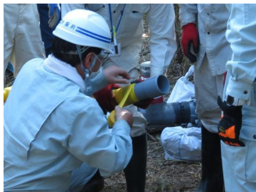
写真8 ホース・塩ビラップ管の接続部
