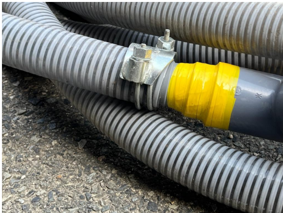
写真3 パワーロックバンドのねじの締付け
