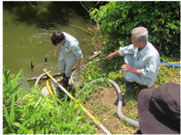
写真2 吸込み口にトラロープを取付ける
