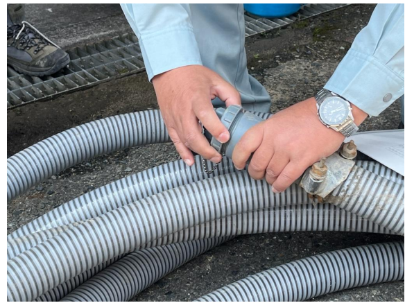
写真4 ねじ式水甲栓の蓋の設置
