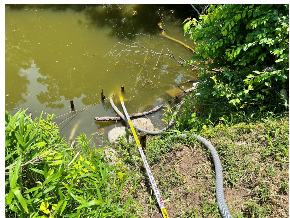
写真10 吸込み口を池の底に近づける (スタッフ等)
