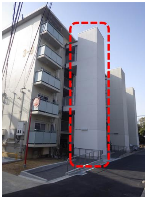
【既存中層住宅エレベーター設置事業】
