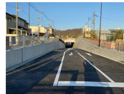
写真3：都市計画道路大県本郷線（R5.3供用）（柏原市）
