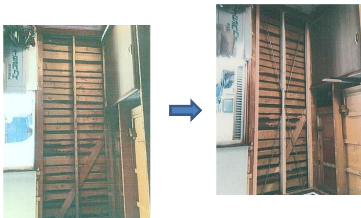
【耐震改修工事】
