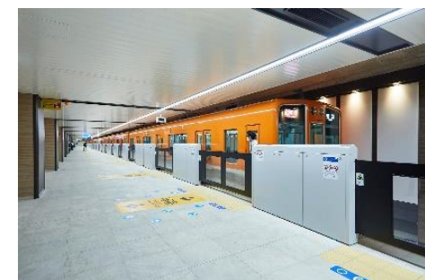
写真 3：可動式ホーム柵整備状況 (阪神 大阪梅田駅)
