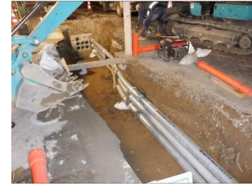
写真 4：国道 176 号（電線共同溝敷設）
