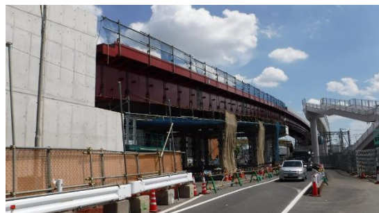
写真1：都市計画道路十三高槻線（正雀工区）（吹田市）
