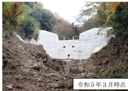
写真4：一の谷砂防堰堤
