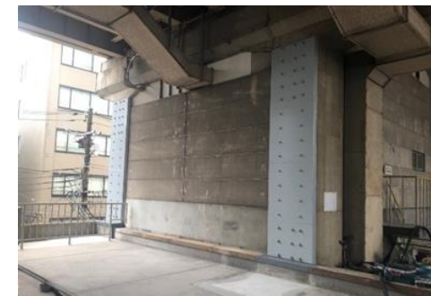
写真 1：鉄道耐震補強状況 (近鉄 布施駅)
