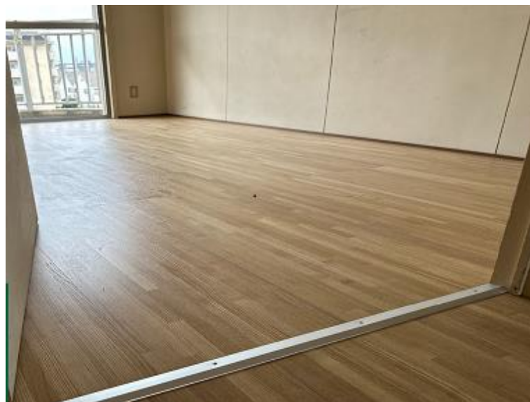
【バリアフリー化事業】 （洋室と台所の床段差解消）
