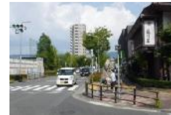
写真3：大阪港八尾線（八尾市）
