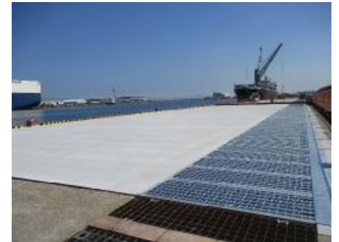
写真2：堺泉北港汐見第3号岸壁 (泉大津市)
