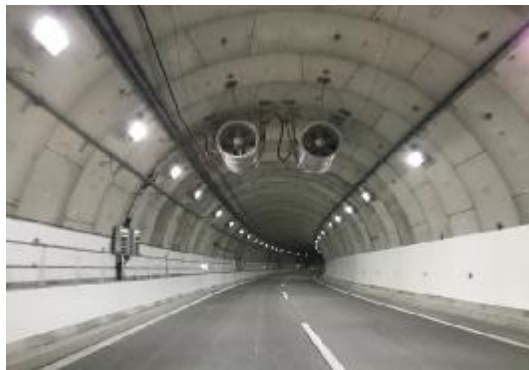
写真1：阪神高速大和川線（R2.3供用）
