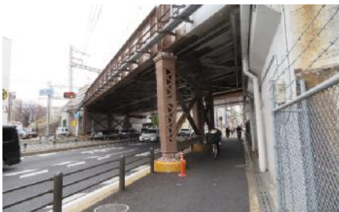
写真 1：鉄道耐震補強状況 (京阪本線 国道 1 号交差部)
