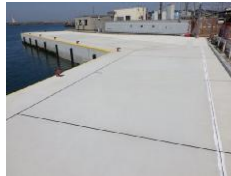
写真1：深日港深日第3号岸壁 (岬町)
