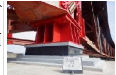
写真4：国道173号福住大橋(耐震補強)
