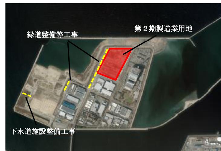
写真1：阪南港阪南2区整備事業(岸和田市)
