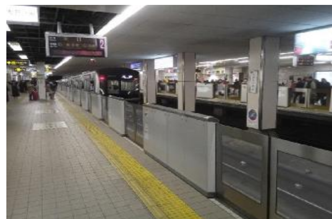
写真 2：可動式ホーム柵整備状況 (Osaka Metro 谷町線 東梅田駅)
