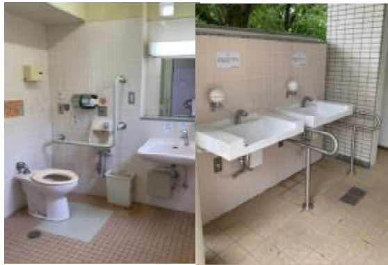
写真2：トイレ改修（服部緑地）
