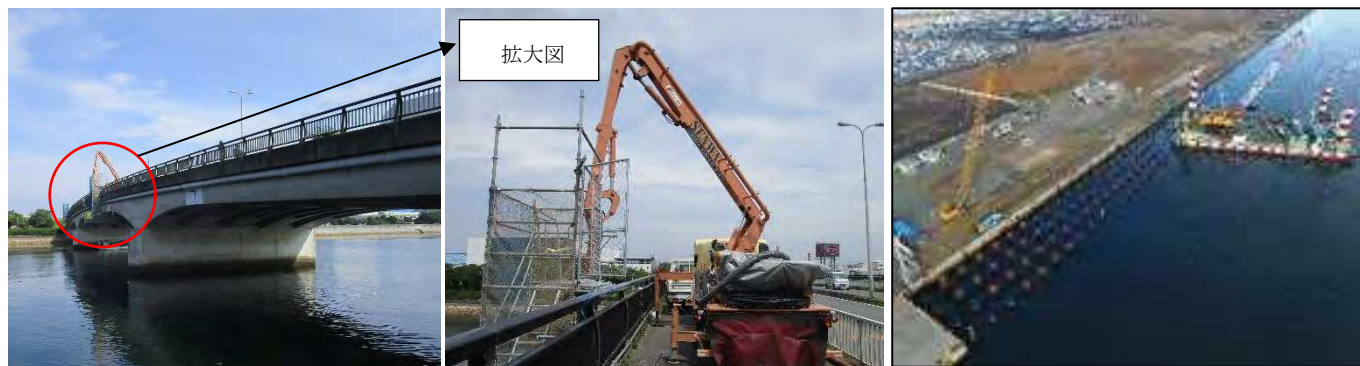
写真1：阪南港貝塚大橋耐震対策工事 コンクリート打設状況(貝塚市)
