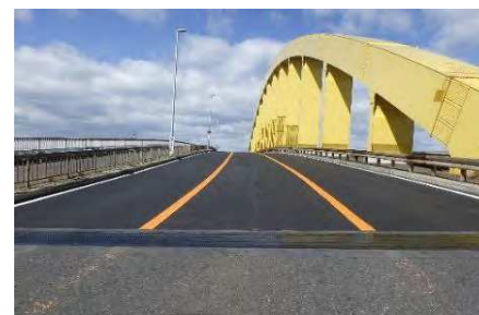
写真3：臨港道路(泉津大橋)補修工事
