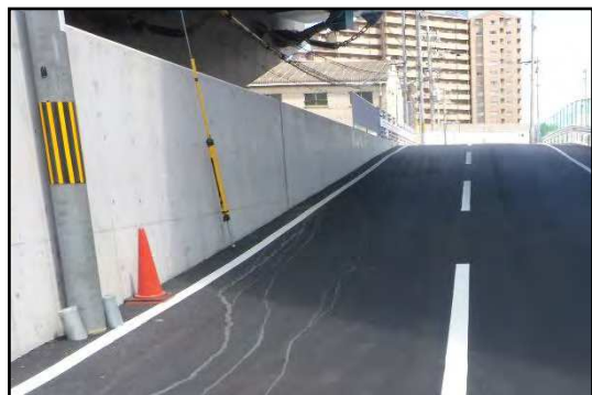
写真1：堺泉北港海岸 堺新港地区【堺市】 (高潮対策)
