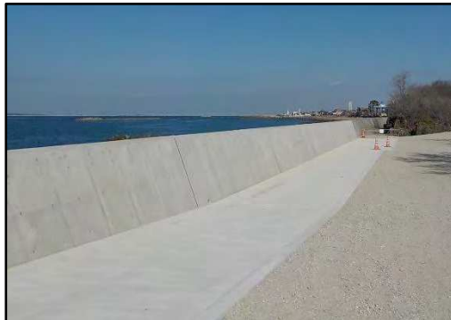
写真2：泉州海岸 貝掛地区【阪南市】 (高潮対策)
